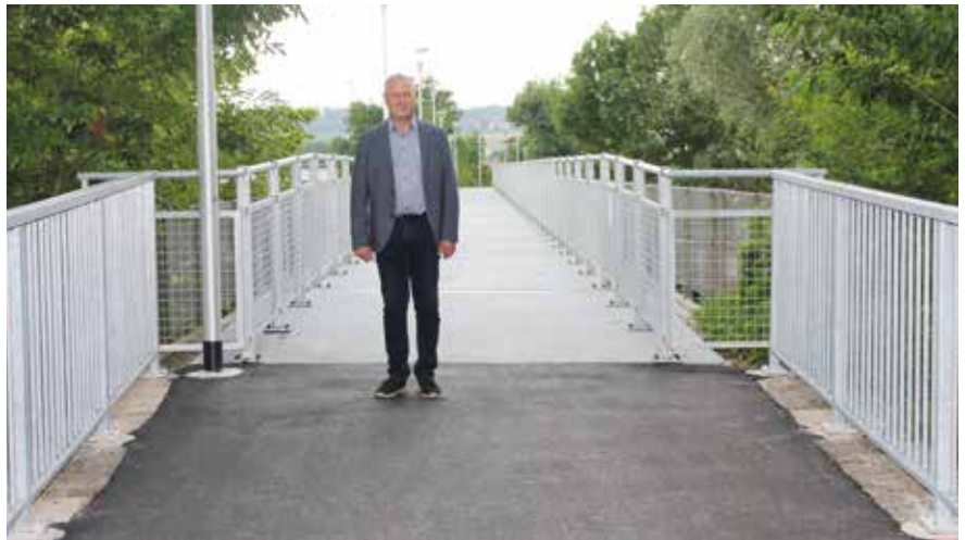
Stadtrat für Bauwesen Herbert Hörmann machte einen Rundgang am Radweg Furtgasse - Breitenreicher Straße - Stadionstraße, der in der Zwischenzeit größtenteils asphaltiert und an gefährlichen Stellen mit Geländern gesichert wurde.
