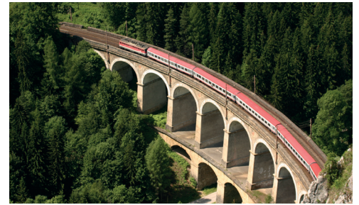
Das Viadukt „Kalte Rinne“ am Semmering
