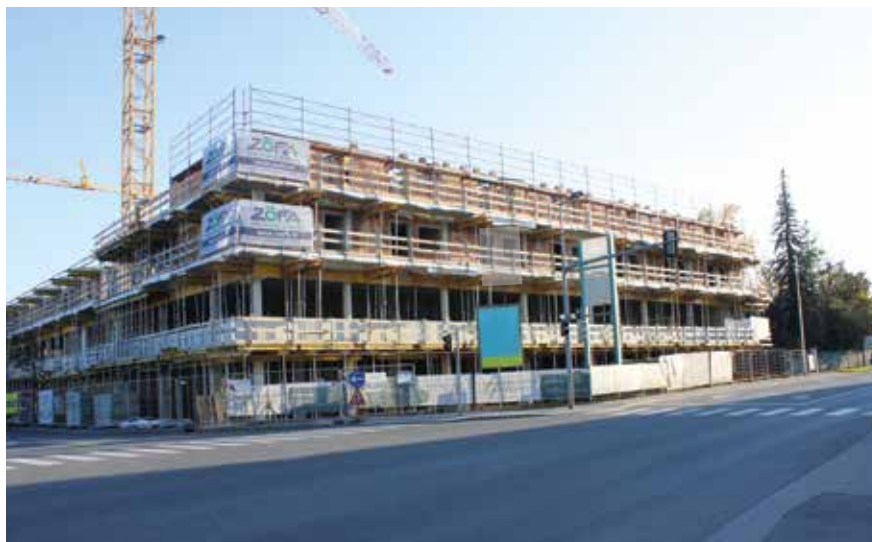
Der aktuelle Baufortschritt beim Stadtquartier
