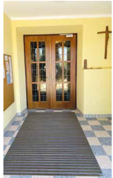
Der sanierte Windfang beim Haupteingang
