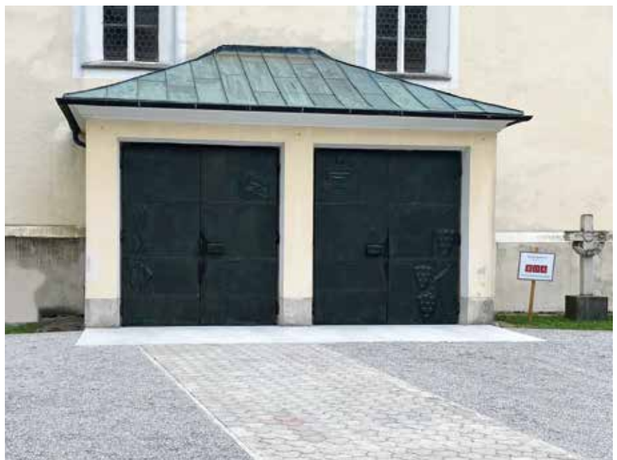
Der Haupteingang nach den Umbauarbeiten
