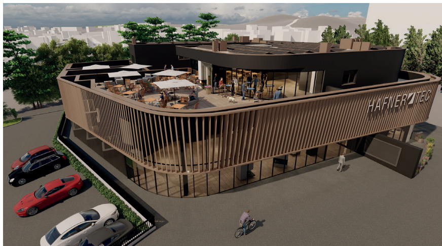
Ein Blickfang bei der Stadteinfahrt in Wieselburg ist hier im Entstehen.
