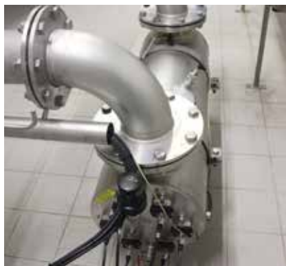
Im Brunnen III wurde unter anderem eine neue UV-Desinfektionsanlage eingebaut.
